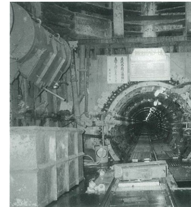
推進シールド・淀漿 シールドの泥水・礫 (レキ)の吸引・回収状況
