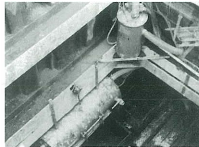
推進シールド・淀漿 シールドの泥水・礫 (レキ)の吸引・回収状況
