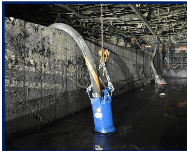
オーストラリア現場稼働状況
