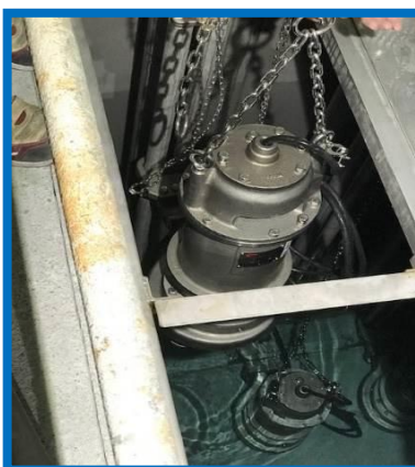
排水ポンプ設置状況
