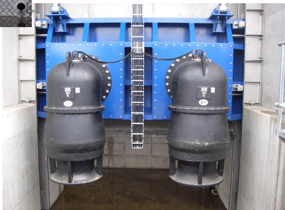
ポンプ据付状況
