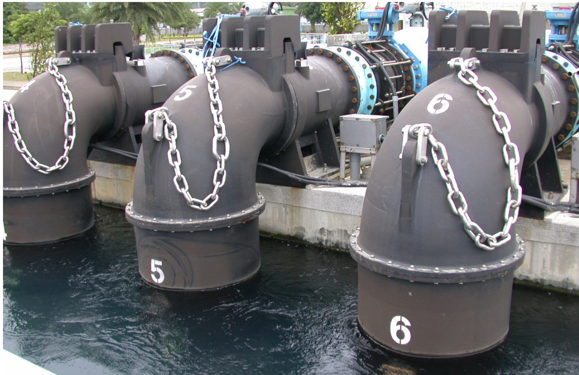
取水口の状況
